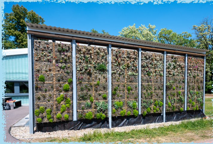
Fassadenbegrünung. (Foto: Sebastian Bischoff)
